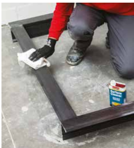
06 Pulire il retro del telaio
