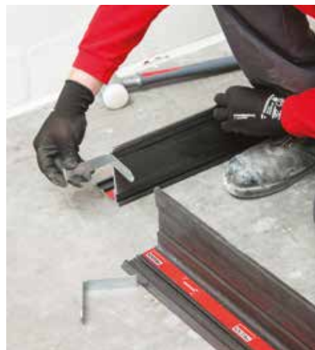
03 Inserire gli angoli di connessione
