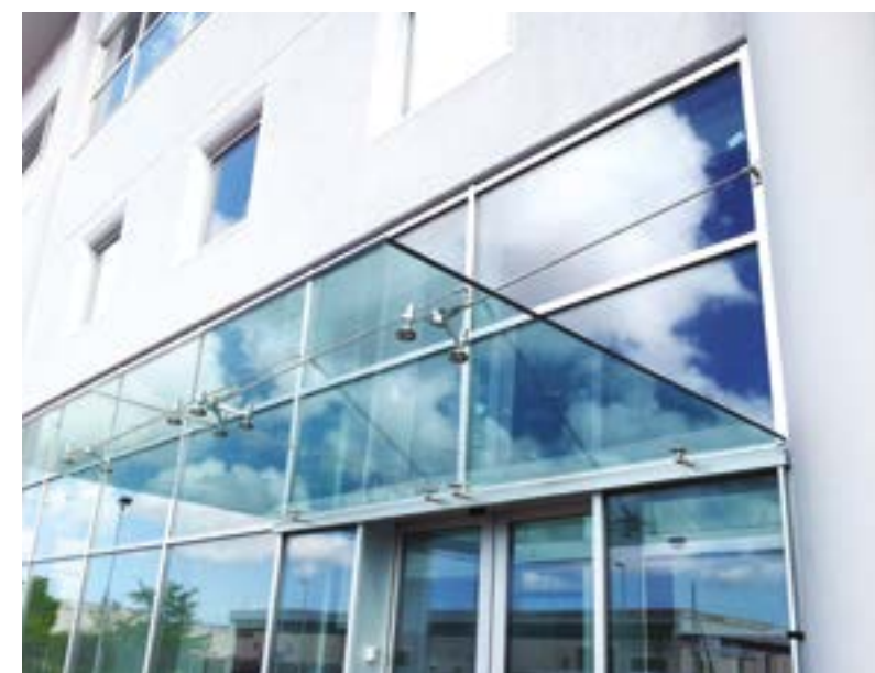
Montaggio pensilina sui montanti di facciata (accessori appositi). Realizzata da C.i.s.m.e.r. a Aprilia.
